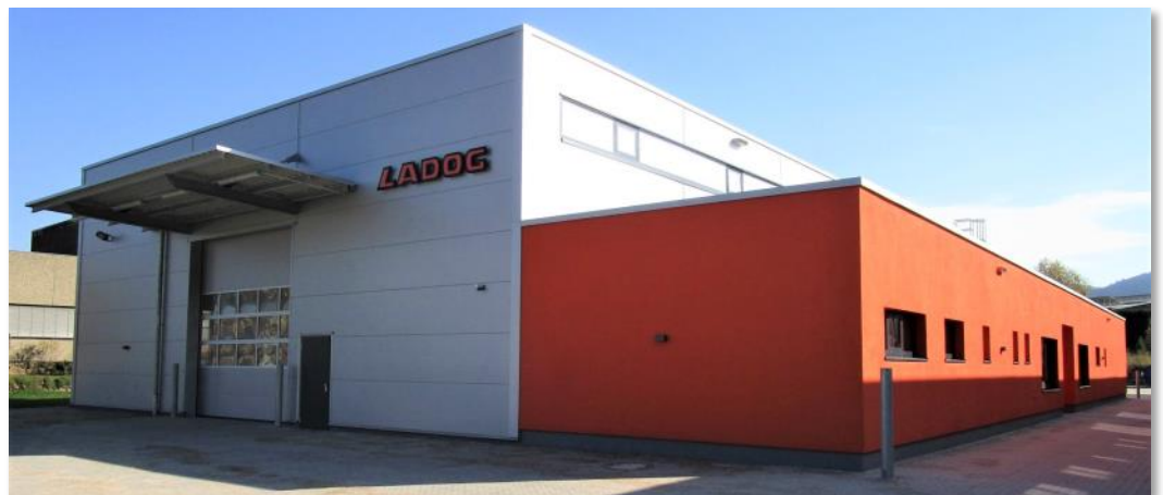
Werk 2 - Schwerpunkt Stahlbau und Lackierung
